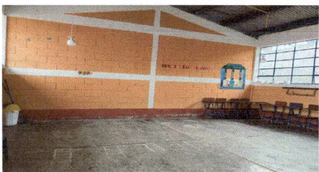
Foto 3: Pintura en muro de interior y exterior
