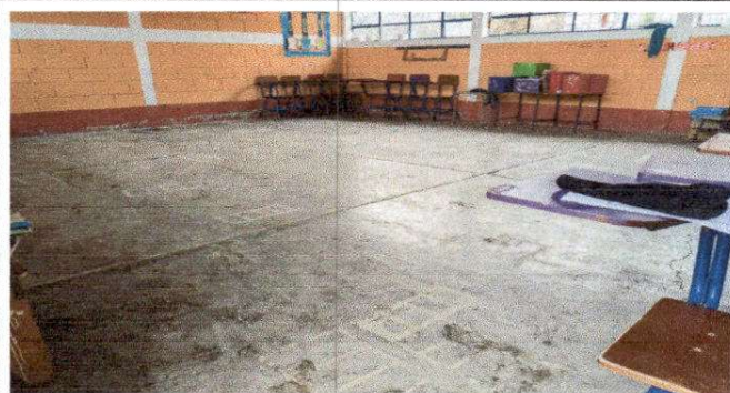
Foto 2: Sustitución de piso de cemento líquido (por cerámico)
